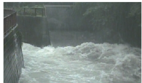
出典：東京都建設局ホームページ 【増水時の目黒川と蛇崩川の合流点】
